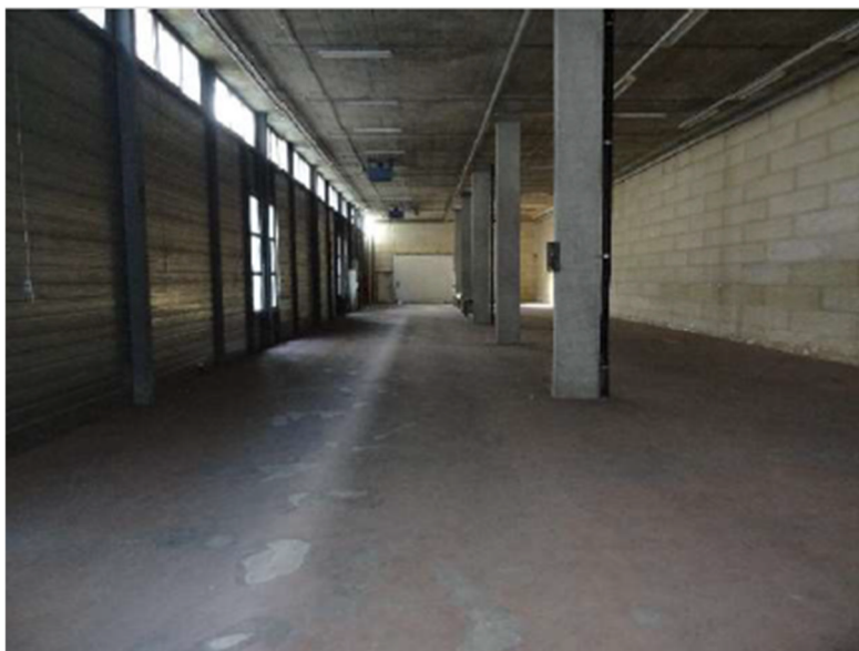
Rez-de-chaussée avec hauteur sous-plafond de 5.53 m et mur en tôle
