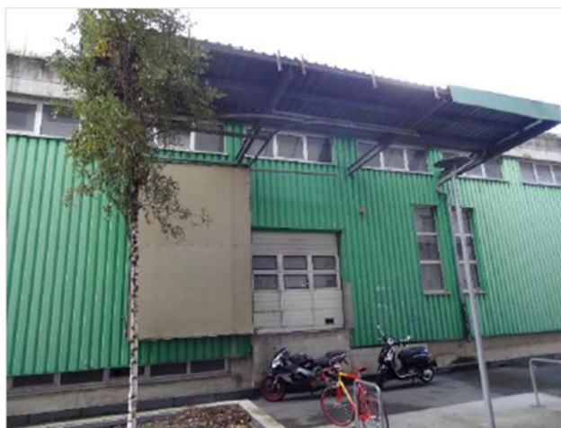
Porte sectionnelle, localisée sur la partie du bâtiment propriété de TFI Trident SA
